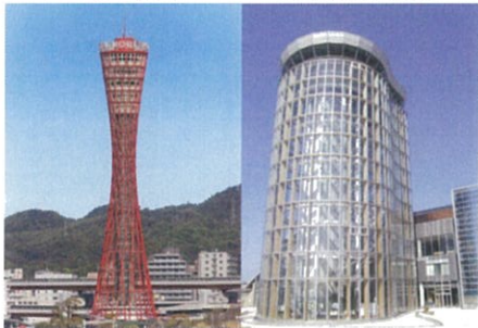
神戸ポートタワー
